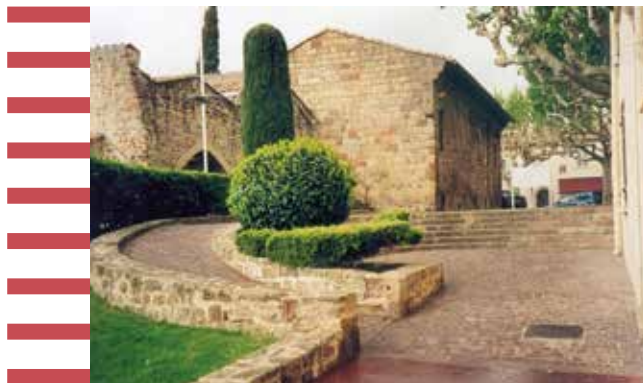
Exemple d'une intégration architecturale réussie d'une rampe d'accès dans un environnement préservé.
