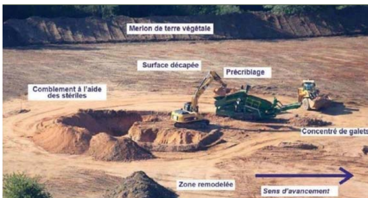
Méthode d'extraction peu invasive (source : Imerys, site de St-Paul-la-Roche)
